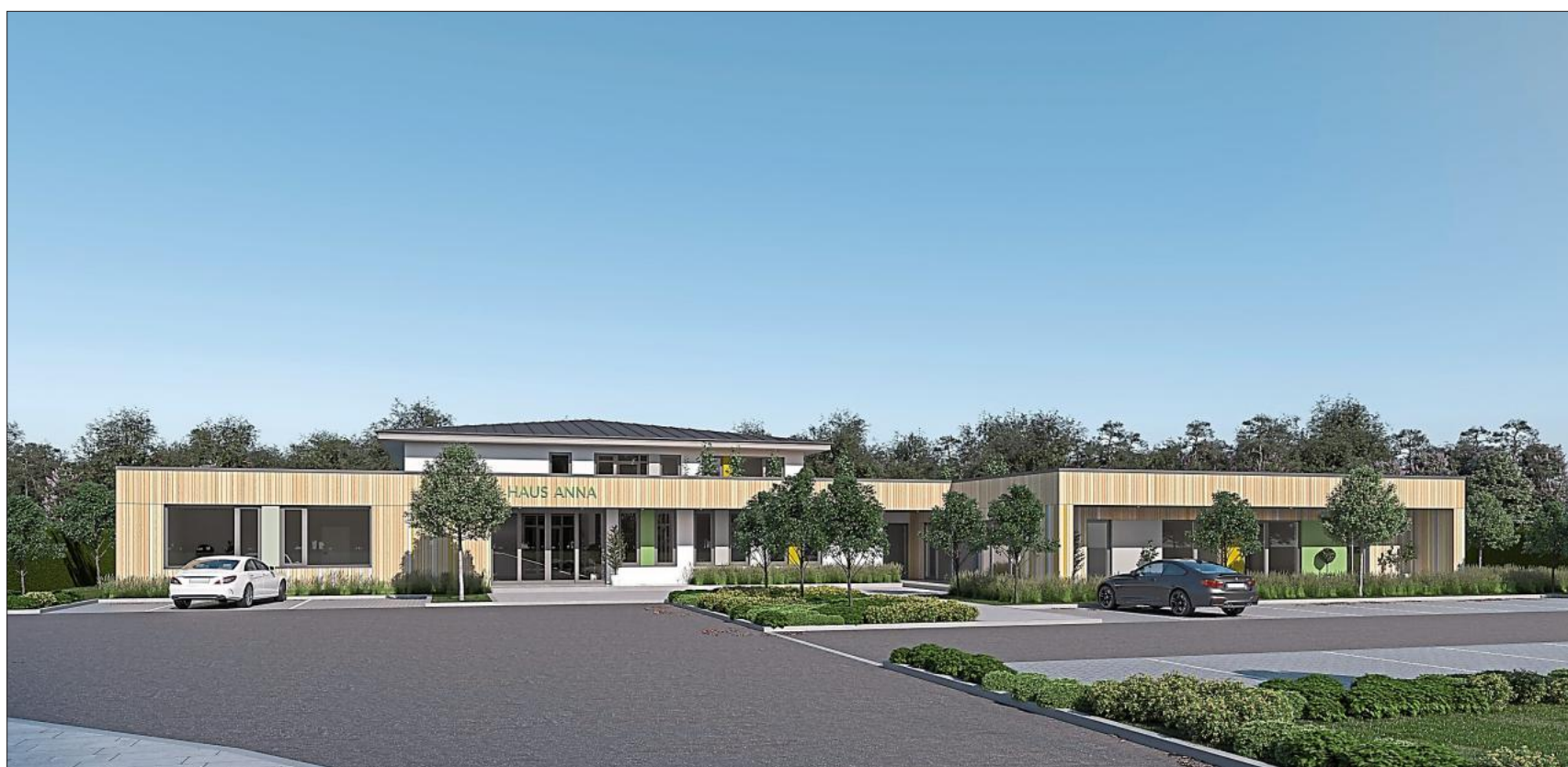
Visualisierung der bereits laufenden Bauarbeiten für das Haus Anna in Eichendorf.
